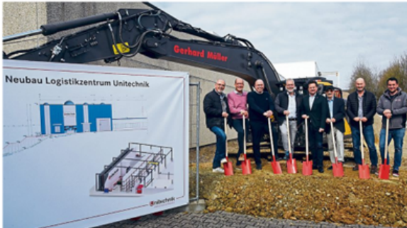
Zum symbolischen Spatenstech versammelten sich u.a. Unternehmensführung, Mitarbeiter und Bürgermeister Ulrich Stacker.
