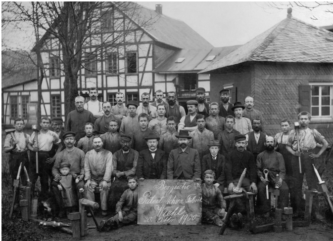
AUS DER DAMALIGEN SCHMIEDE SIND HEUTE HOCHMODERNE PRODUKTIONSHALLEN GEWORDEN
